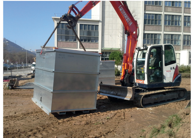
Manipulation d'une cuve métallique à l'aide d'un tracto-pelle
