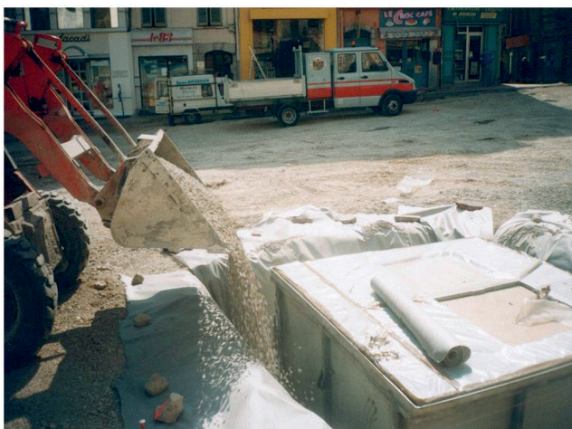
Remblaiement (selon notice de pose)
