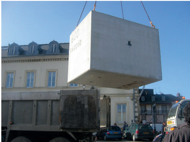
Manipulation d'une cuve béton, à l'aide d'une grue 50 tonnes
