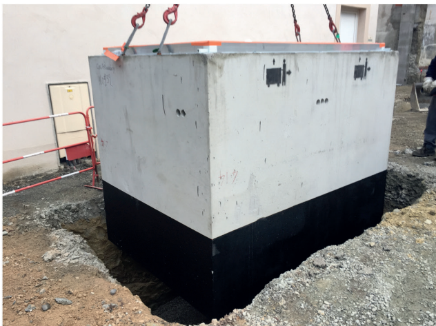
Pose d'une cuve béton en fond de fosse
