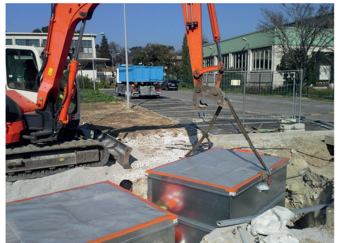
Pose d'une cuve métallique en fond de fosse
