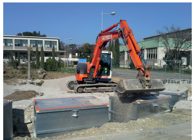
Remblaiement (selon notice de pose)
